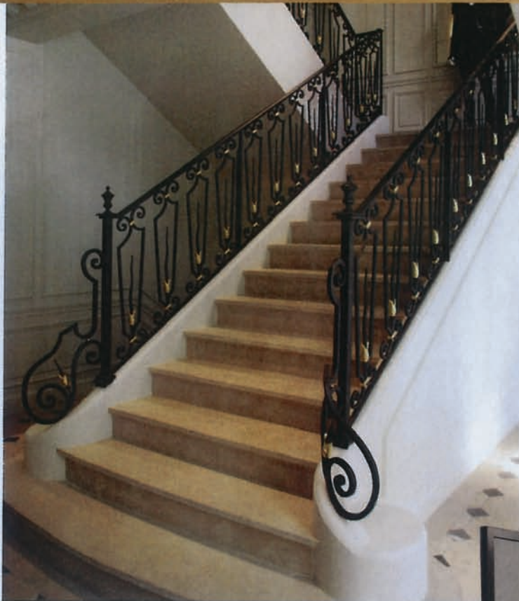
LA RAMPE DE L'ESCALIER DE LA BOUTIQUE BALMAIN À PARIS A ÉTÉ RÉALISÉE À LA DEMANDE DE L'ARCHITECTE JOSEPH DIRAND AINSI QUE DES HABILLAGES POUR LES VITRINES ET PORTES OU LA STÈLE MIROIR.
